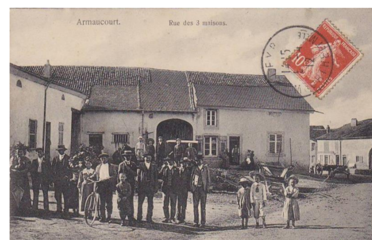
Rue des 3 maisons
