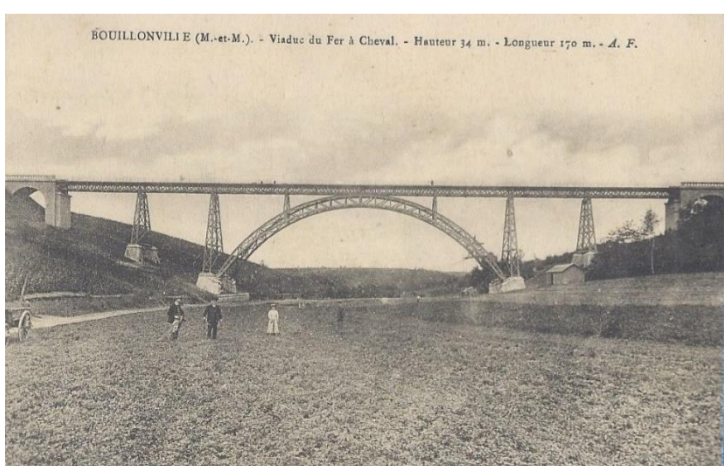
Viaduc du "Fer à cheval"
