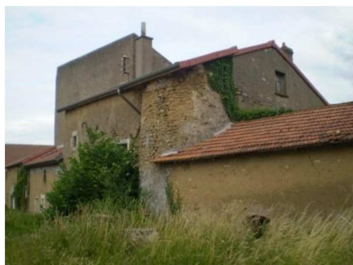
Tour ronde sur l'arrière du château au lieu dit « la Horgne »
