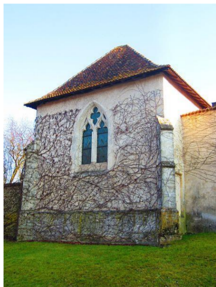
Chapelle Casenove (Casa Nova) XVI e : porche.
